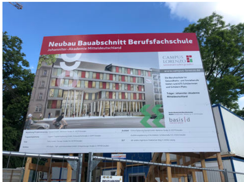
Fotos: Thomas Hajek (Dezember 2020 Blick in Richtung Riebeckstraße; Baustellenschild: Zukünftige Ansicht von der Riebeckstraße)
